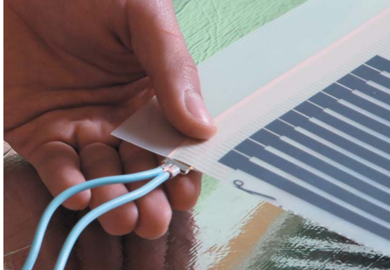
Рис. 14. Соединение монтажных проводов с контактным зажимом
