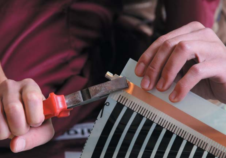
Рис. 8. Крепление контактного зажима к термопленке
