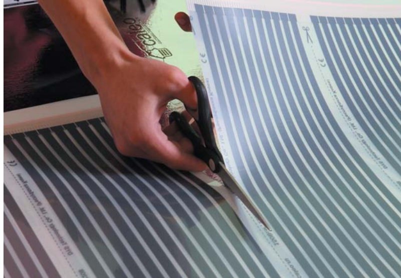
Рис. 5. Разрезание термопленки CALEO по линиям отреза
