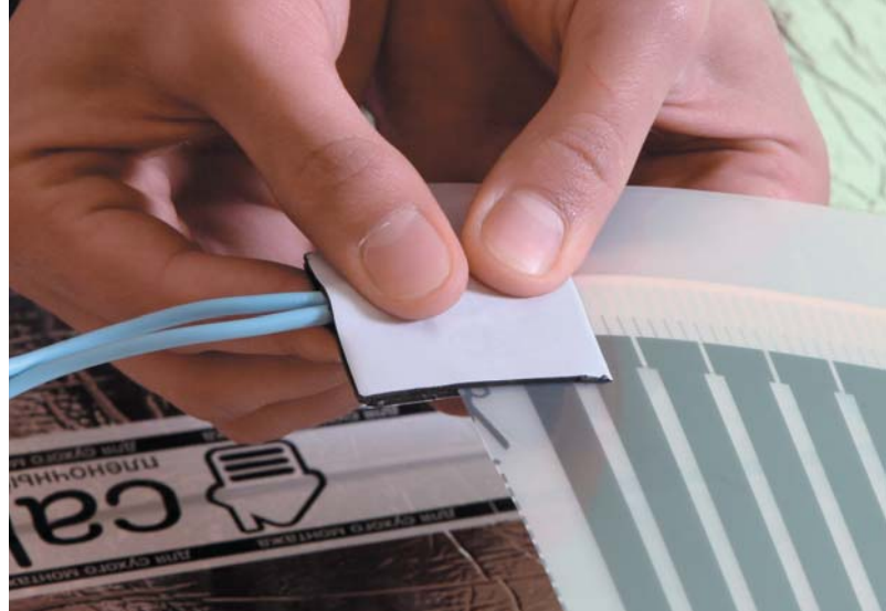
Рис. 18. Установка верхнего листа изоляции
